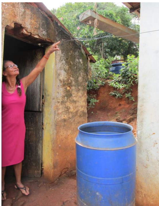
Figura 22- Armazenamento de água da chuva ao redor de casa em tonéis de 250L, com captação por calha
