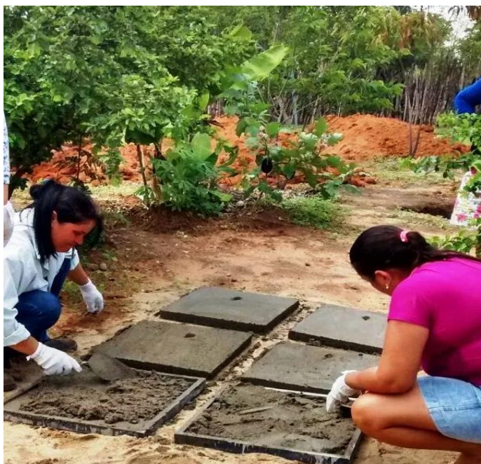
Figura 20- Biofiltro Água Viva
