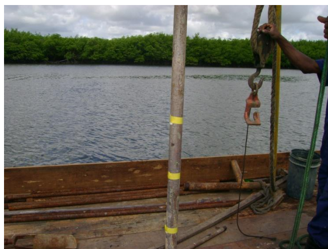
Controle de execução
