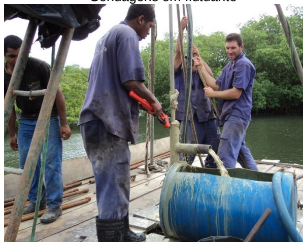
Execução da sondagem
