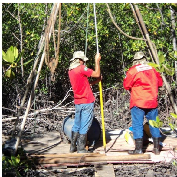
Locação topográfica com GPS RTK
