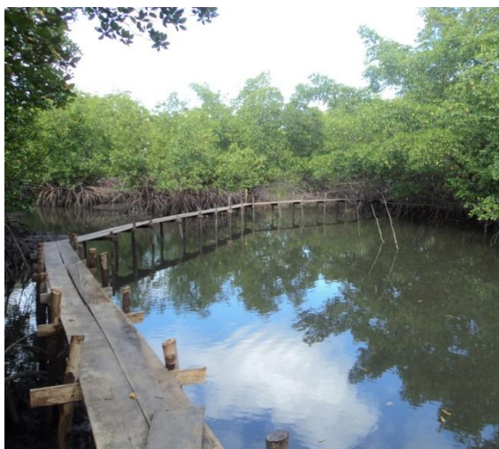
Passarelas construídas para o acesso de Sondagens
