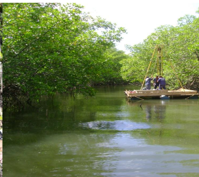
Sondagens em flutuante
