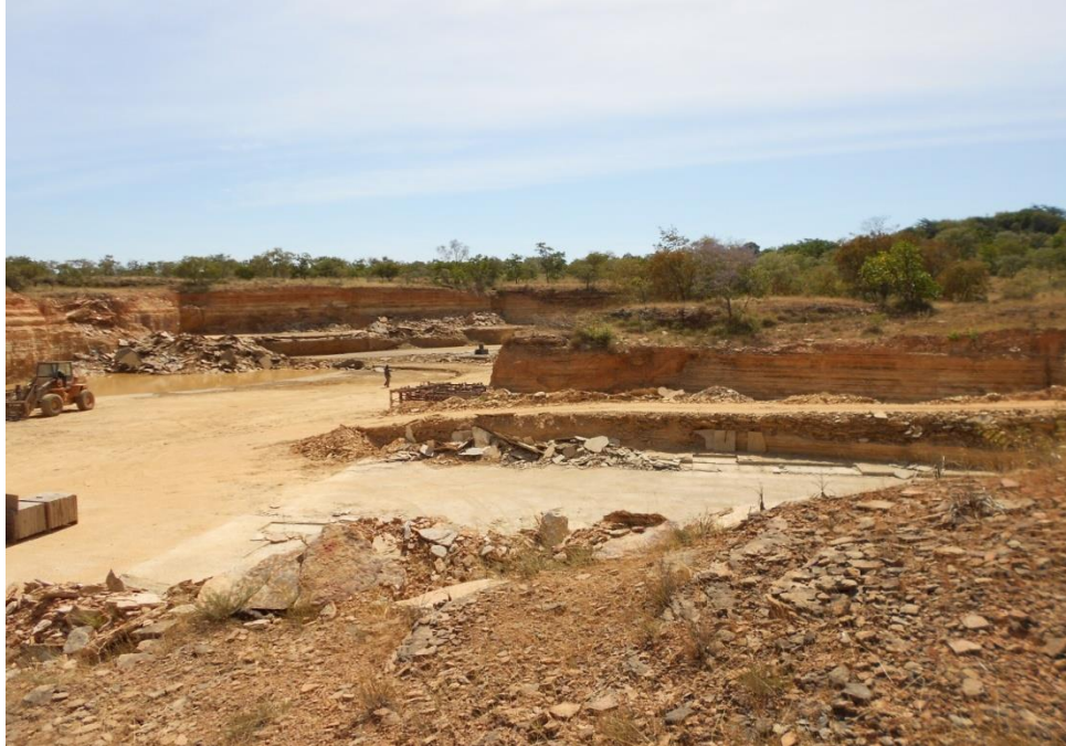
Figura 3. Área de extração mecanizada de quartzito, de forma organizada, onde o espaço de extração é separado do espaço de descarte do rejeito, causando dano ambiental de grande extensão. Mina localizada no município de Castelo do Piauí, PI.
