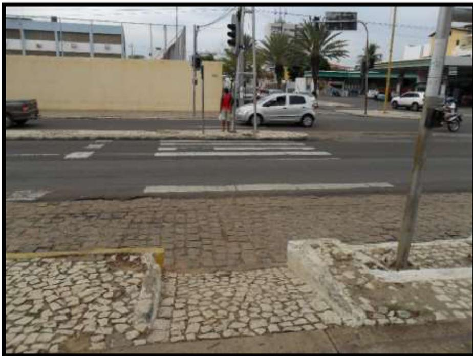
Figura 9: Rebaixamento de rampa na faixa de travessia da Av. Cardoso de Sá.
