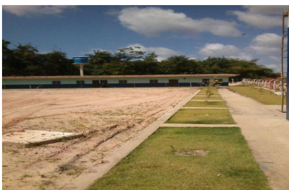
Figura 9 – Prédio da Administração do Aterro Sanitário
