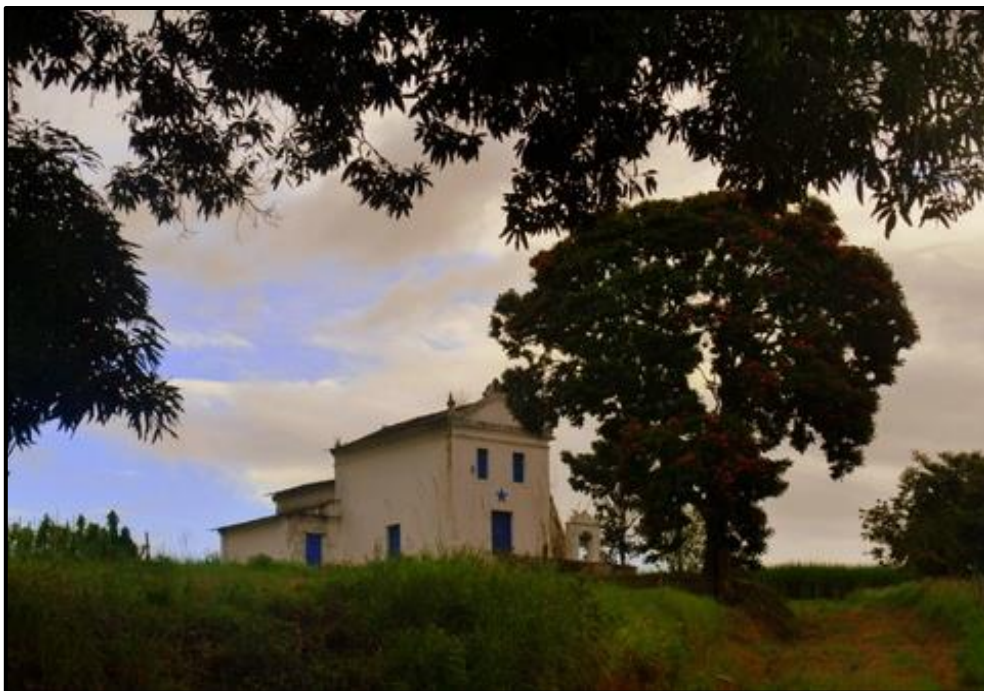
Figura 2 - Capela do Engenho. Foto: Rute Barbosa
