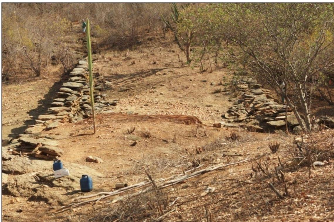
**Figura 53** – Barragem com visão das duas faces e do aterro intermediário. *Fonte: acervo da FUMDHAM.*
