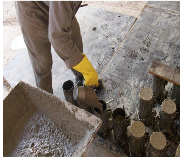
Figura 6: Colocação do concreto nos moldes
