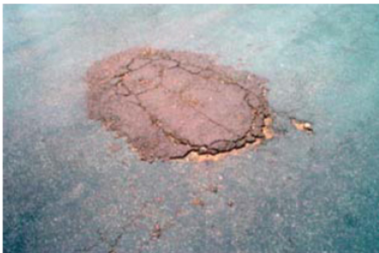
Figura 3.10 – Remendo Trincado
