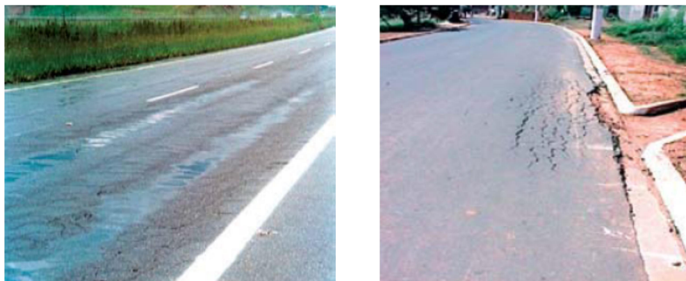
Figura 3.4 – Afundamento
