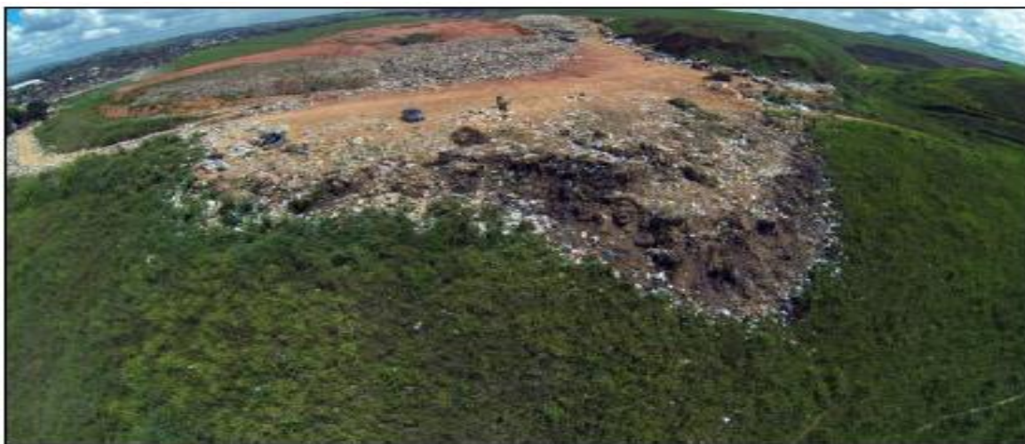
Figura 7- Aterro de Garanhuns esgotado, 2014.
