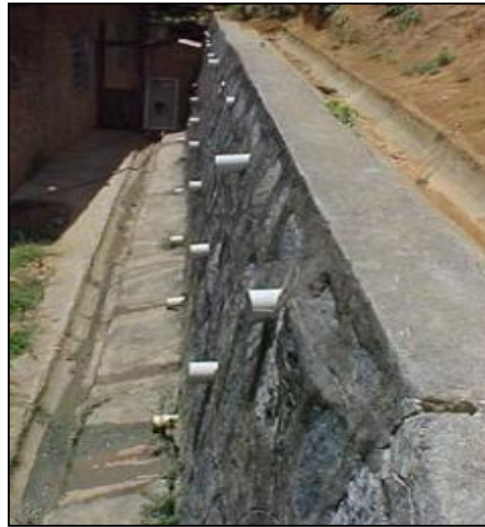
Foto 3.6 - Muro de arrimo de pedra argamassada
