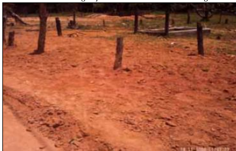
Foto 4.8 – Retirada da vegetação na área da Comunidade Córrego da Areia
