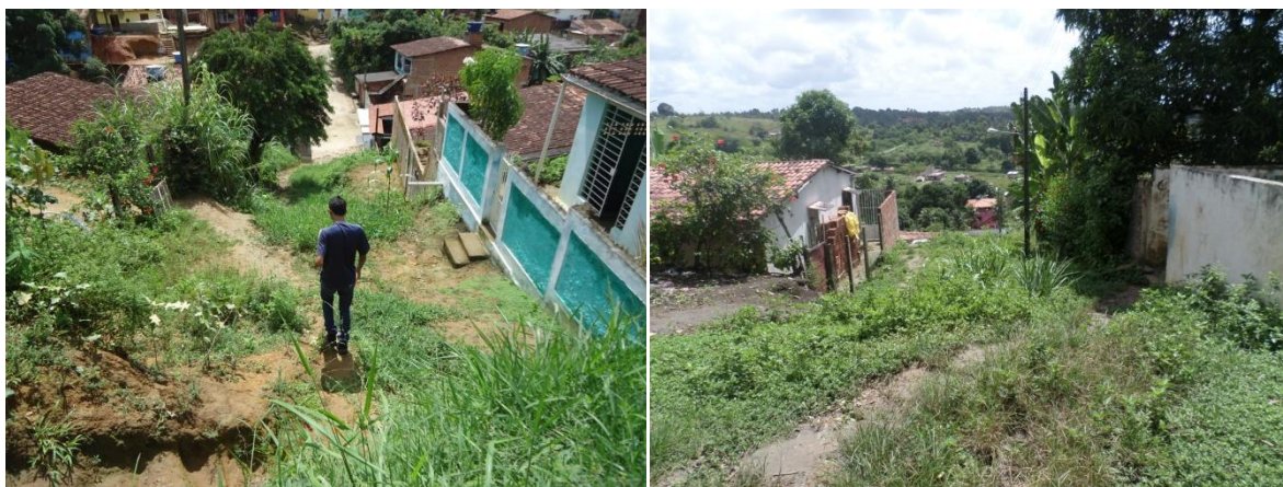
Foto 6.1 – (a) Acesso improvisado às casas do Setor 10; (b) Acesso improvisado às casas do Setor 9.
