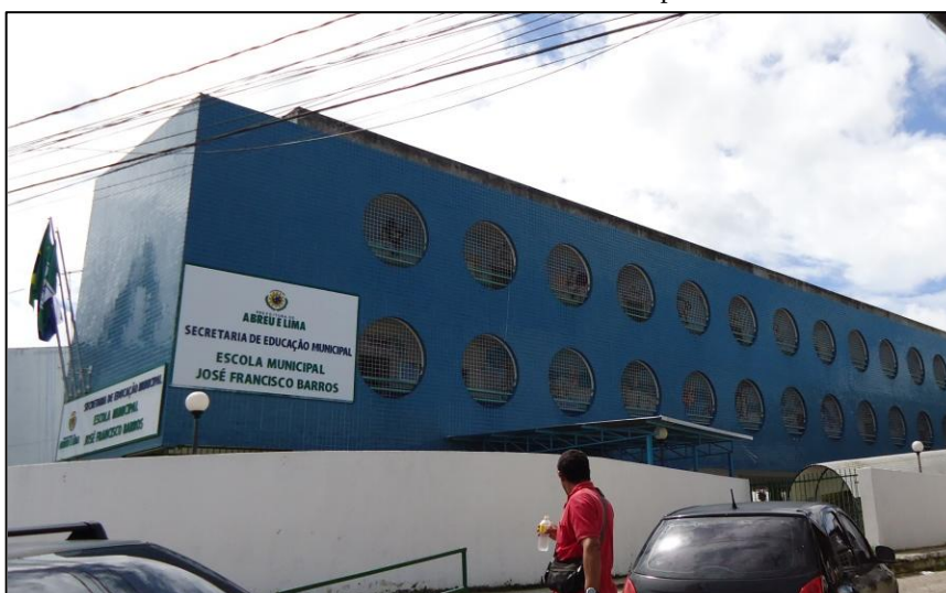
Foto 5.5 – Elemento de interesse mapeado
