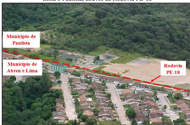
Figura 4.6 - Vista aérea da sede administrativa da ESEC e da divisão territorial entre os municípios de Abreu e Lima e Paulista, através da Rodovia PE-18
