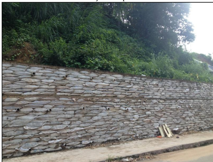
Foto 3.8 – Muro de contenção do tipo solo-cimento ensacado.
