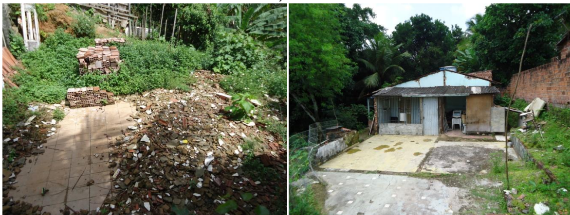
Foto 6.3 – (a) Casa demolida por recomendação da Defesa Civil na área do Setor 5; (b) Casa demolida por recomendação do PMRR.
