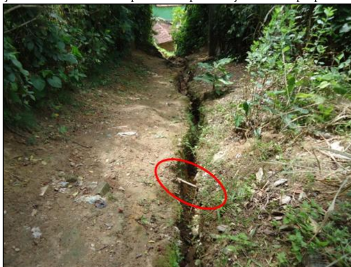
Foto 3.5 – Formação de ravina de erosão provocada pelo lançamento inadequado de águas servidas.
