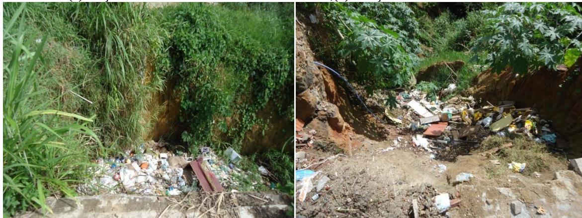
Foto 6.6 – (a) Lançamento de lixo em encosta do Setor 3; (b) Lançamento de lixo em encosta do Setor 5
