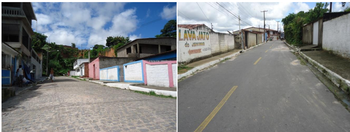
Foto 6.5 – (a) Rua de acesso ao Setor 1; (b) Rua de acesso ao Setor 12.
