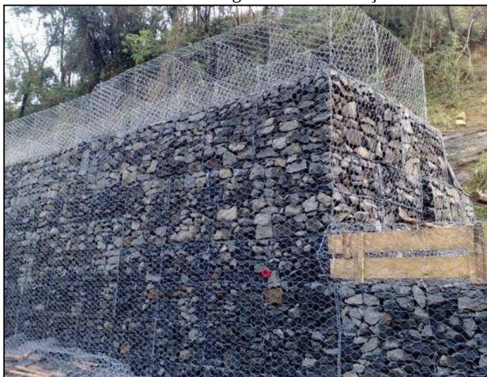
Foto 3.7 – Muro gabião em construção
