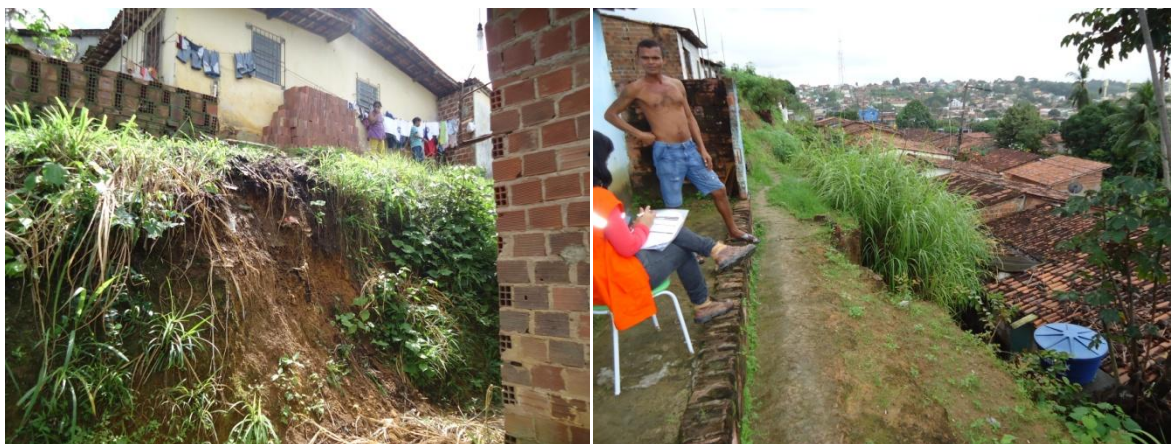
Foto 6.2 – (a) Proximidade da casa em relação ao topo do talude apresentando risco de deslizamento. Local: Setor 4; (b) Proximidade de casas em relação ao topo do talude (risco de deslizamento), e proximidade de casas em relação à base do talude (risco de soterramento). Local: Setor 2.
