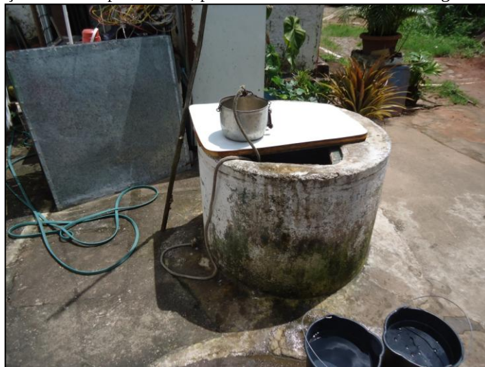
Foto 4.2 – Poço artesanal tipo cacimba, perfurado em área urbana sem esgotamento sanitário
