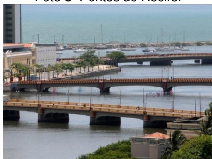
Foto 3- Pontes do Recife.
