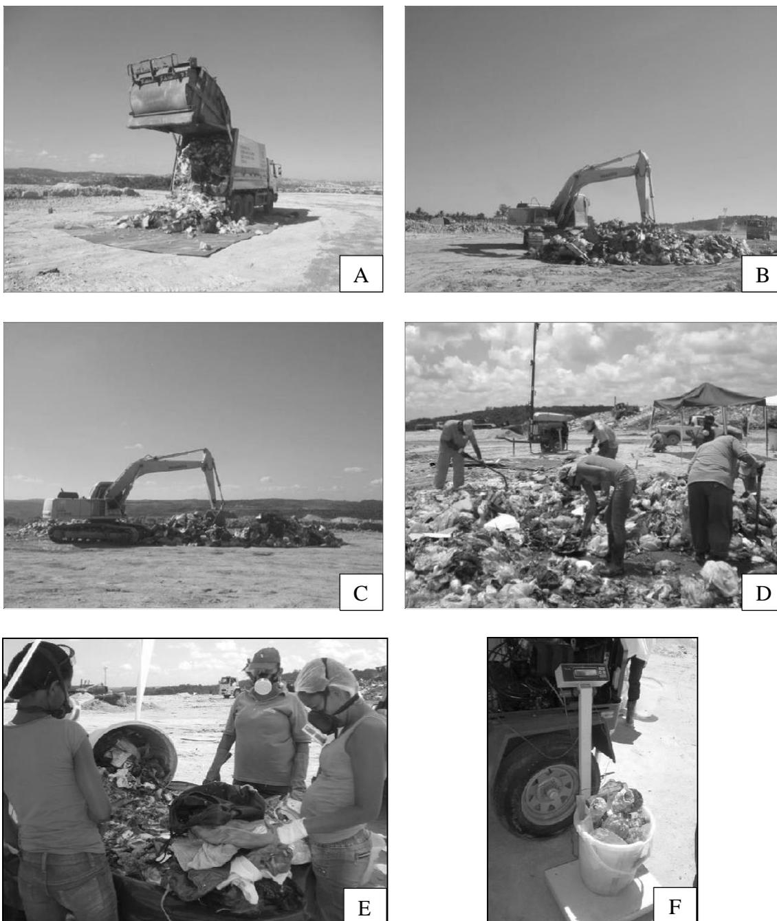
**Figura 9.** Processo de coleta ou amostragem de RSU para a realização da composição gravimétrica: (A) basculação, (B) homogeneização, (C) quarteamento dos resíduos, (D) rompimento dos sacos, homogeneização manual e coleta de amostras, (E) triagem e, (F) pesagem dos resíduos. Fonte: Elaborado pelo autor.
