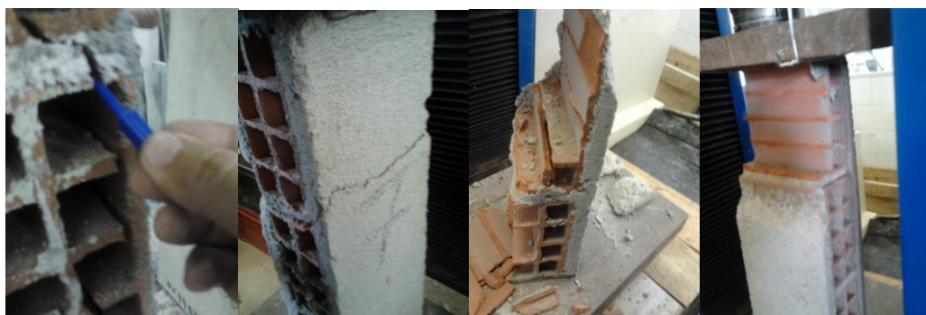
Figura 3.10 - (a): Prisma com septos rompidos por tração; (b): ruptura por tração dos septos e revestimento (amostra 2); (c): ruptura explosiva, chapisco aderente e septos destruídos; (d): Ruptura brusca. septos rompidos por tração (amostra 2)
