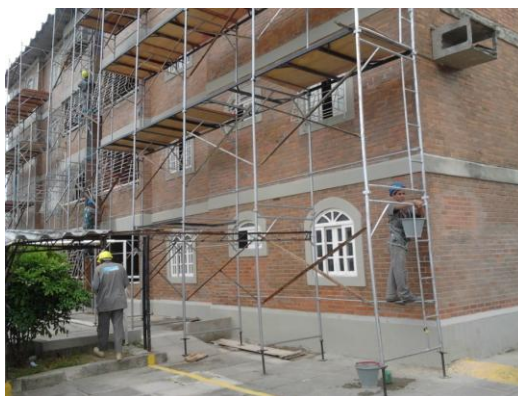
Figura 5.14 – Prédio com alvenaria resistente sem revestimento
