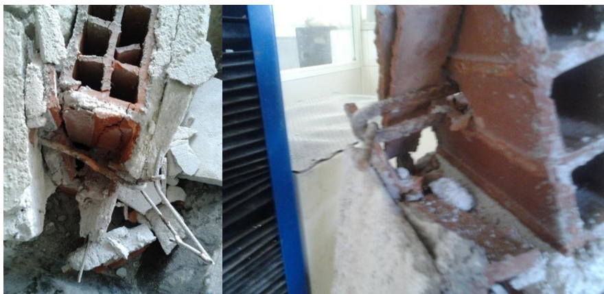
Figura 6.12 – Estado íntegro dos conectores após ensaios e demolição com marreta dos restos do prisma
