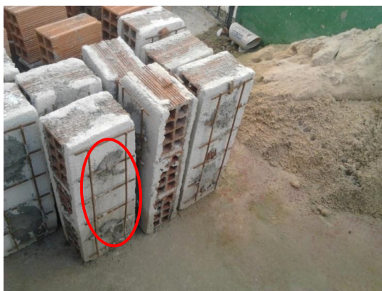
Figura 3.7 – Amostra 3 pronta para receber a argamassa de reforço (em vermelho os dois conectores chumbados com argamassa)
