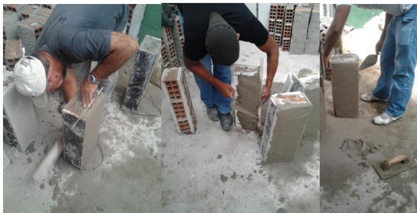
Figura 5.15 – Formas e gabarito de madeira com régua de alumínio sendo usadas na aplicação das argamassas para reforço dos prismas
