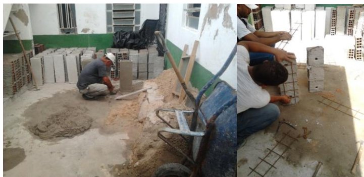
Figura 5.13 – Setor posterior da área destinada à confecção dos prismas, e instalação das armaduras dos prismas
