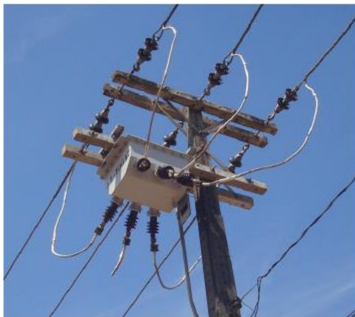
Figura 2.3 Chave Tripolar isolada a óleo
