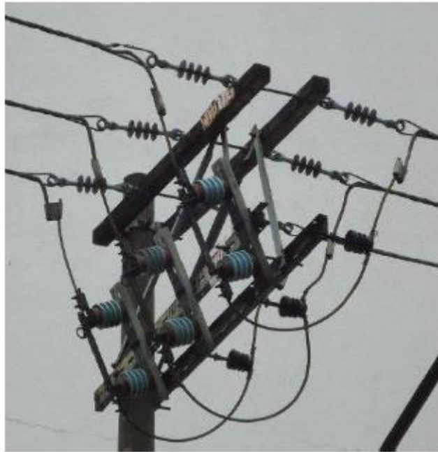
Figura 2.2 Chave Seccionadora Unipolar
