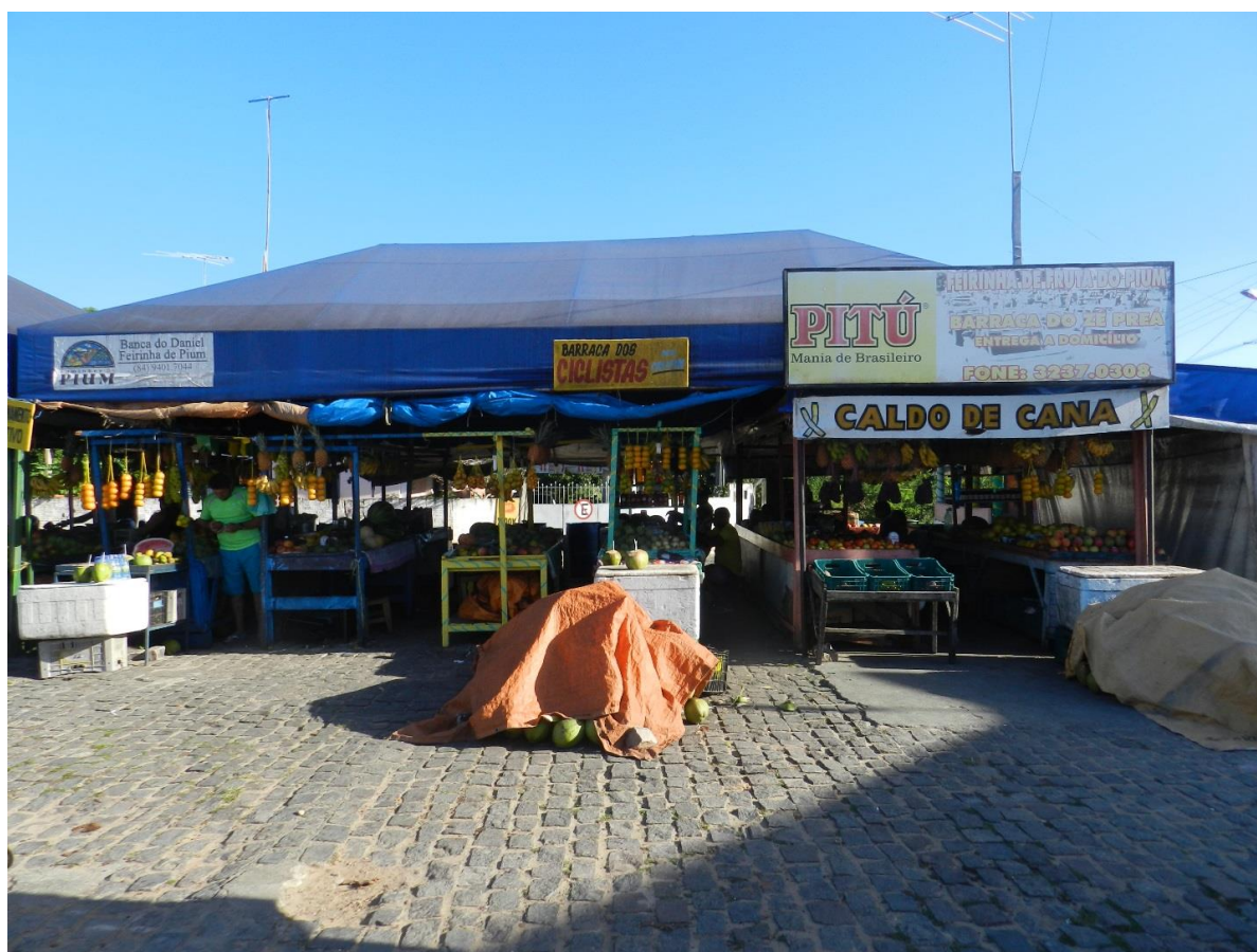
Figura 38 – Vista frontal da estrutura sobre as bancas de feira para proteger os hortifrúteis e as pessoas dos raios solares no pátio da Feira Livre de Pium/RN
