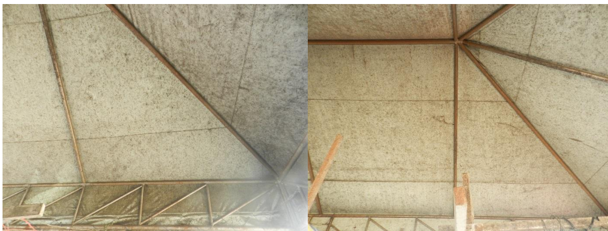
Figura 39 – Vista parcial da estrutura sobre as bancas de feira para proteger os hortifrúteis e as pessoas dos raios solares no pátio da Feira Livre de Pium/RN
