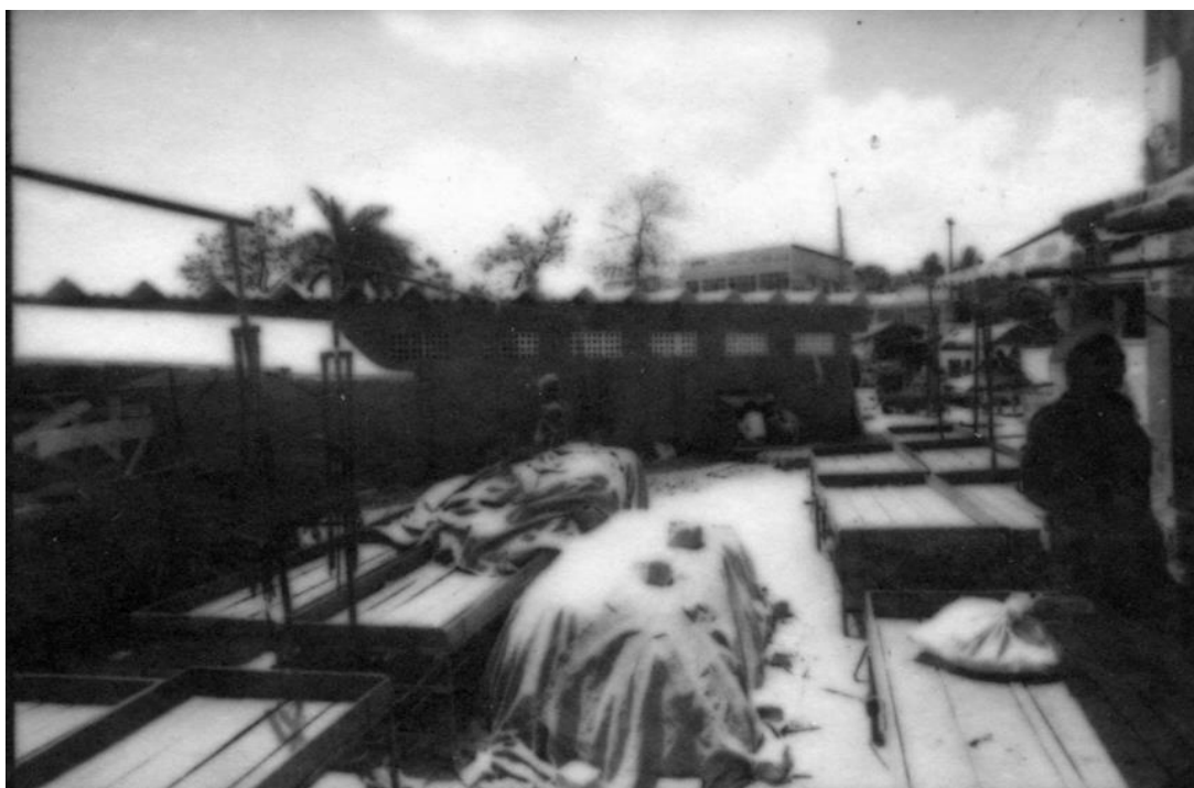
Figura 27 – Lavatório do Pátio da Feira de Casa Amarela (16.12.1982)
