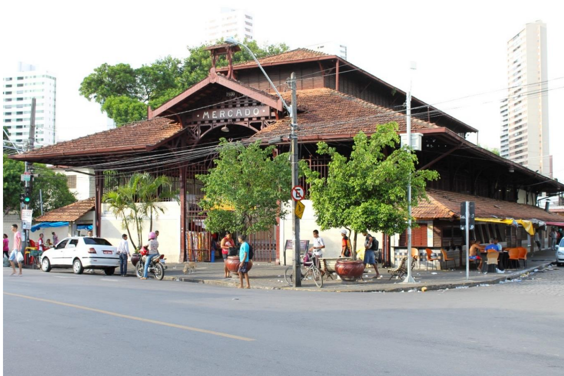
Figura 12 – Vista frontal do Mercado Público de Casa Amarela, zona Norte da cidade do Recife Fonte: Rogério Cavalcanti, 2014
