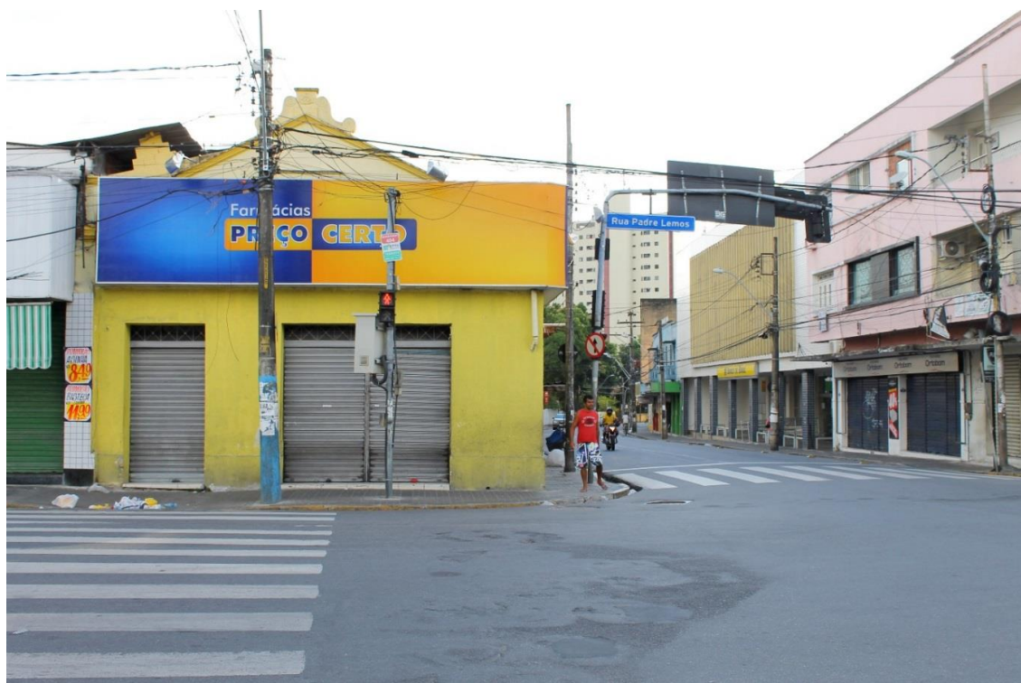
Figura 13 – Vista frontal da antiga edificação que deu origem ao nome do bairro (Casa Amarela), zona Norte da cidade do Recife. Nota: embora descaracterizada, a edificação continua pintada de amarelo. Fonte: Rogério Cavalcanti, 2014
