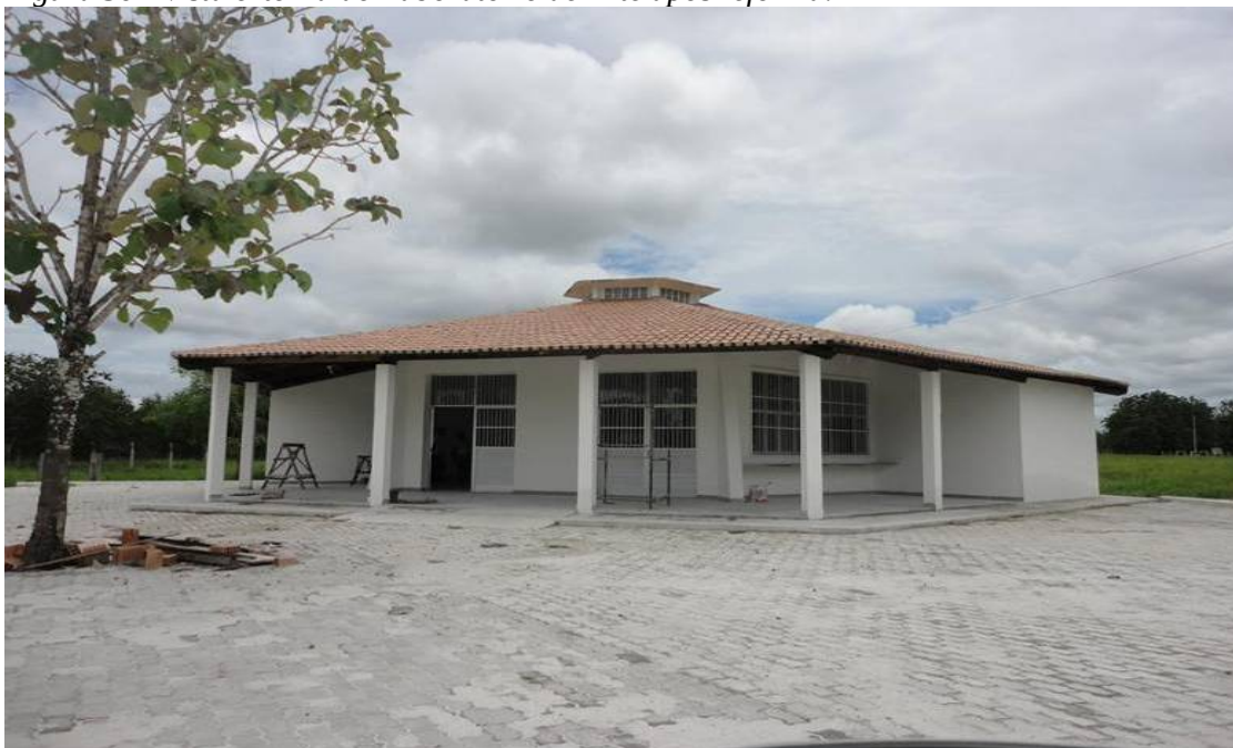
Figura 30 - Vista externa do Laboratório de Arte após reforma.
