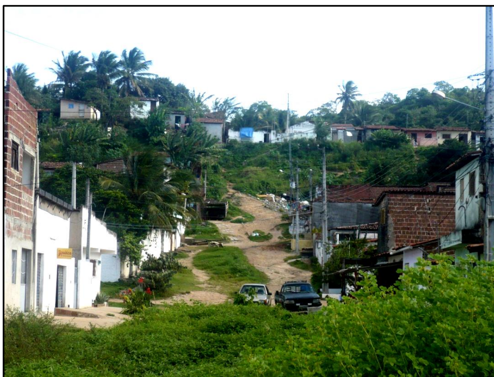
Figura 2 – Ocupação desordenada em curso no topo de cordão dunar localizado na porção norte da ZPA 1, caracterizando-se áreas de risco (SILVA JÚNIOR, 2012).
