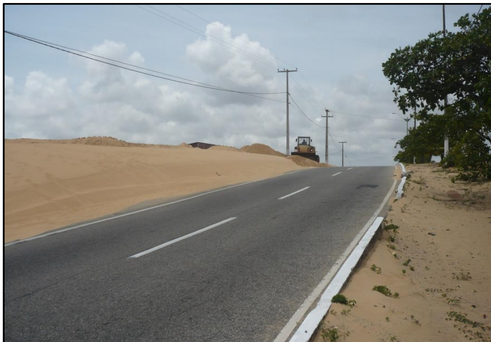
Figura 24 – Ocupação da Av. Pref. Omar O’Grady por sedimentos oriundos da Subzona de Uso Restrito (SZ2) da ZPA 1, em decorrência da erosão eólica do campo dunar em processo de ocupação. (Silva Júnior, 2012).
