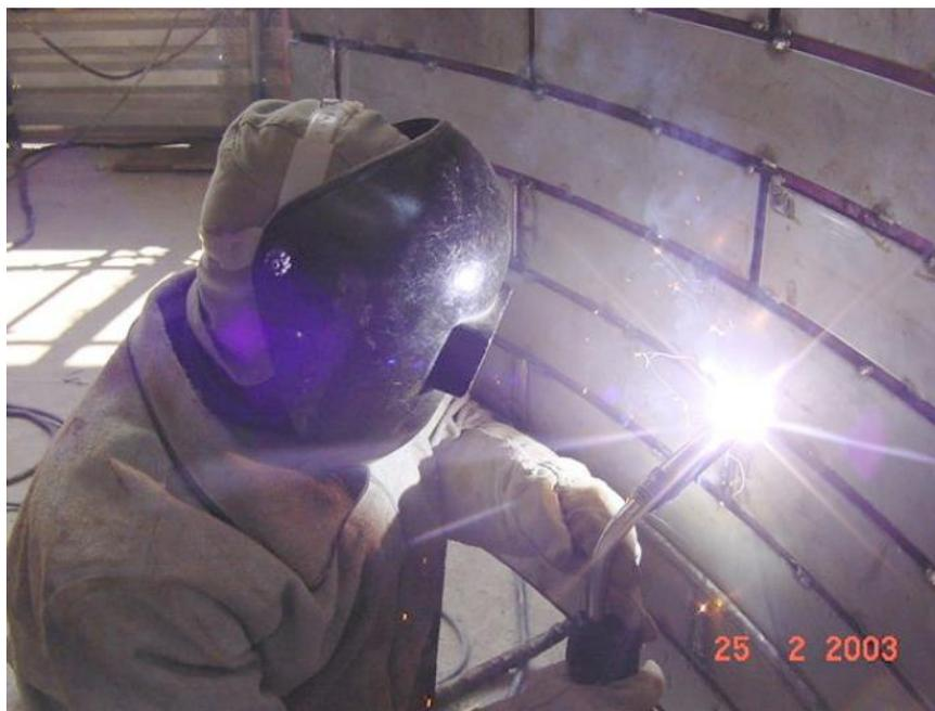
Figura 2.25 - Representação da soldagem interna do revestimento interno de lining em torre de destilação (ABDALLA, 2005 *apud* BALDUCCI *et al*, 2004).
