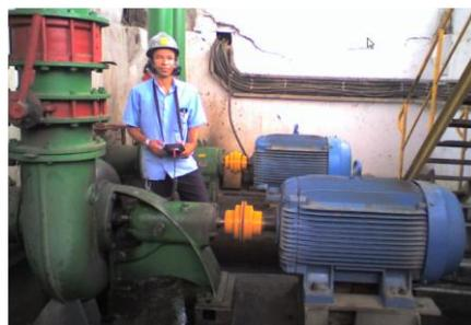
Figura 1.1-Análise de vibração em um conjunto motor e bomba.
