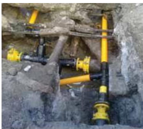
Figura 2.13 – Intervenção de sistemas de terceiros na rede da Light (Fonte: Rangel Júnior, 2011)
