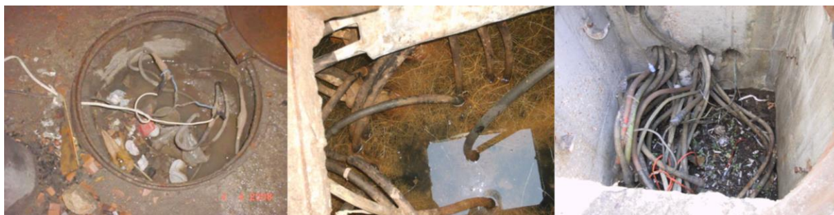
Figura 2.11 – Acúmulo de sujeira, esgoto e alagamento nas câmaras subterrâneas (Fonte: Light, 2008; Stone & Webster, 2001)
