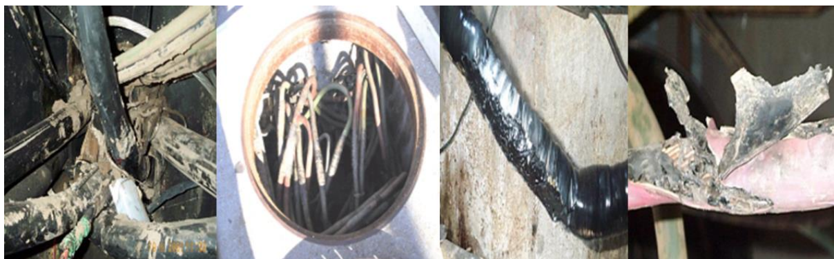
Figura 2.10 – Câmaras subterrâneas com alta densidade de cabos (Esquerda) e falhas no isolamento (Direita) (Fonte: Stone & Webster, 2001)
