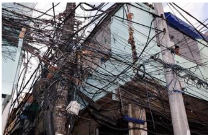
Figura 2.12 – Sobrecarga da rede local devido a ligações de “gatos” (Fonte: Light, 2011b)
