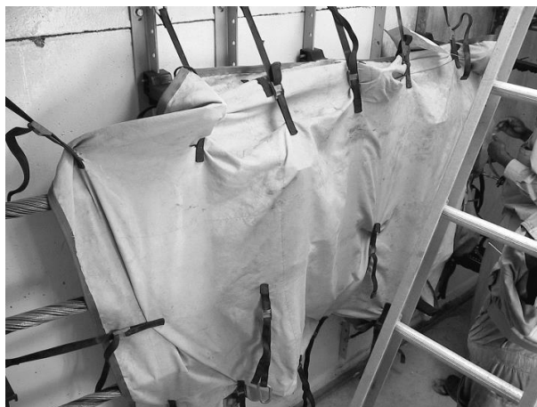
Figura 2.28 – Cobertor protetor de junções e conectores (Fonte: Hamel et al. (2005))
