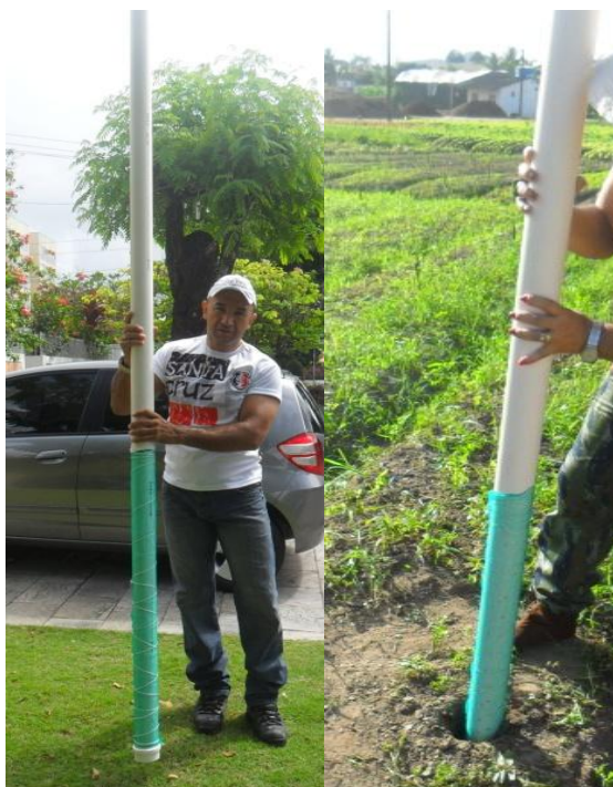
Figura 15 – Tubo de PVC perfurado com tela filtrante e introdução do poço na área de estudo
