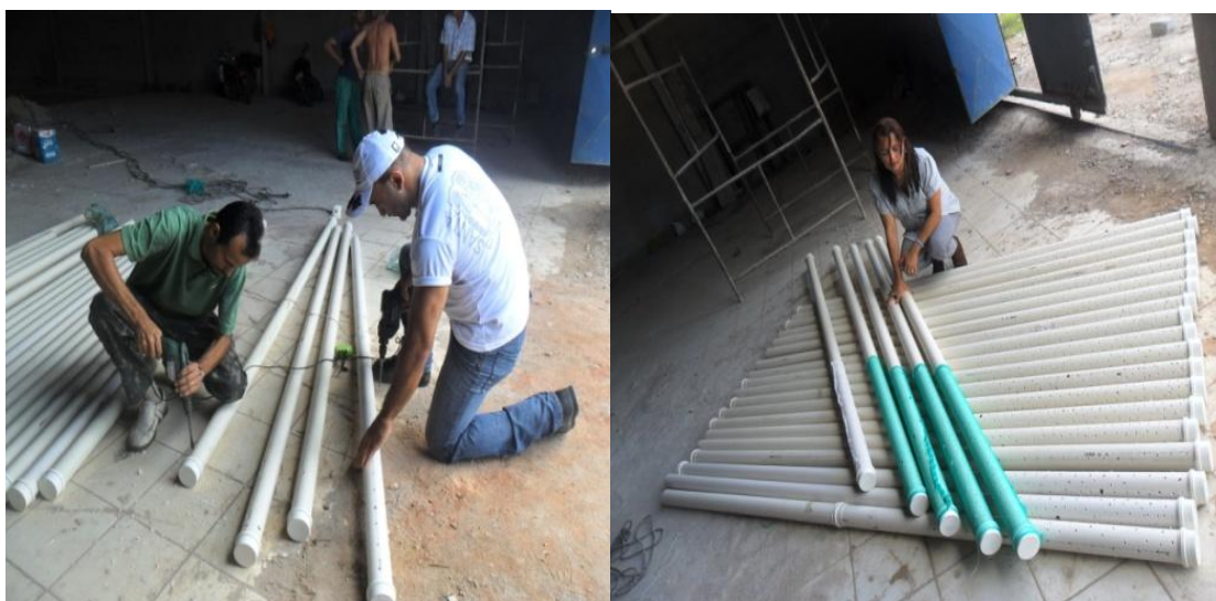
Figura 13- Construção dos poços na área experimental
