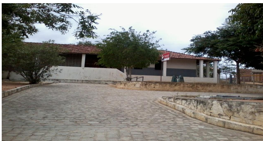
Fachada da escola e praça da comunidade Foto: Denise Torres
