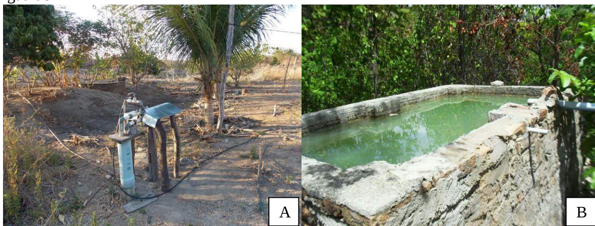
Figura 94 – Bomba elétrica e caixa d'água para captação e armazenamento de água subterrânea na área de entorno da nascente do afluyente do riacho da Volta, Município de Iguaraci-PE
