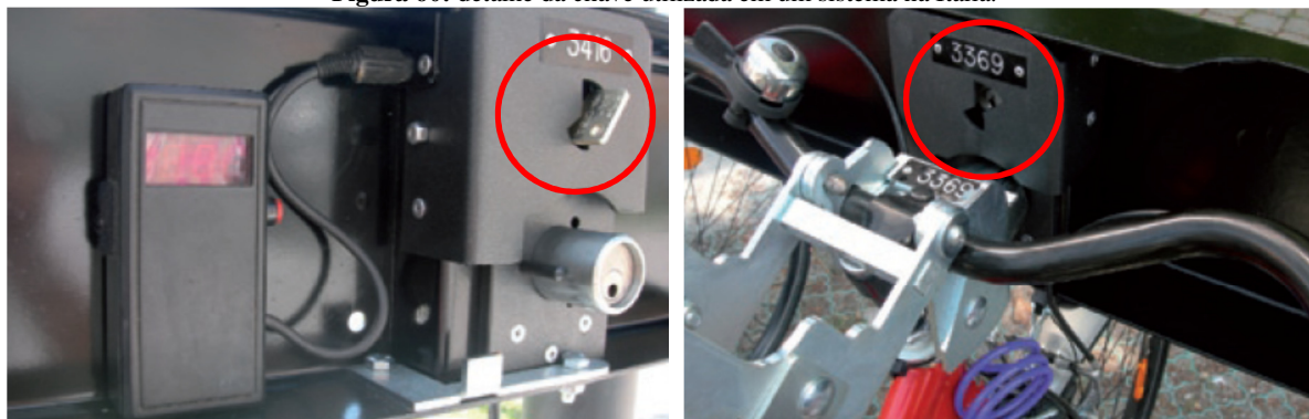
Figura 60: detalhe da chave utilizada em um sistema na Itália.
