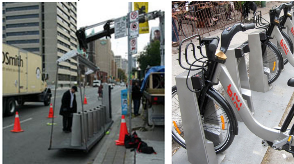
Figura 68: estações com módulos portáteis, sistema BIXI (Montreal, Canadá): à esquerda, a instalação de uma estação e, à direita, bicicletas travadas em um dos módulos.
