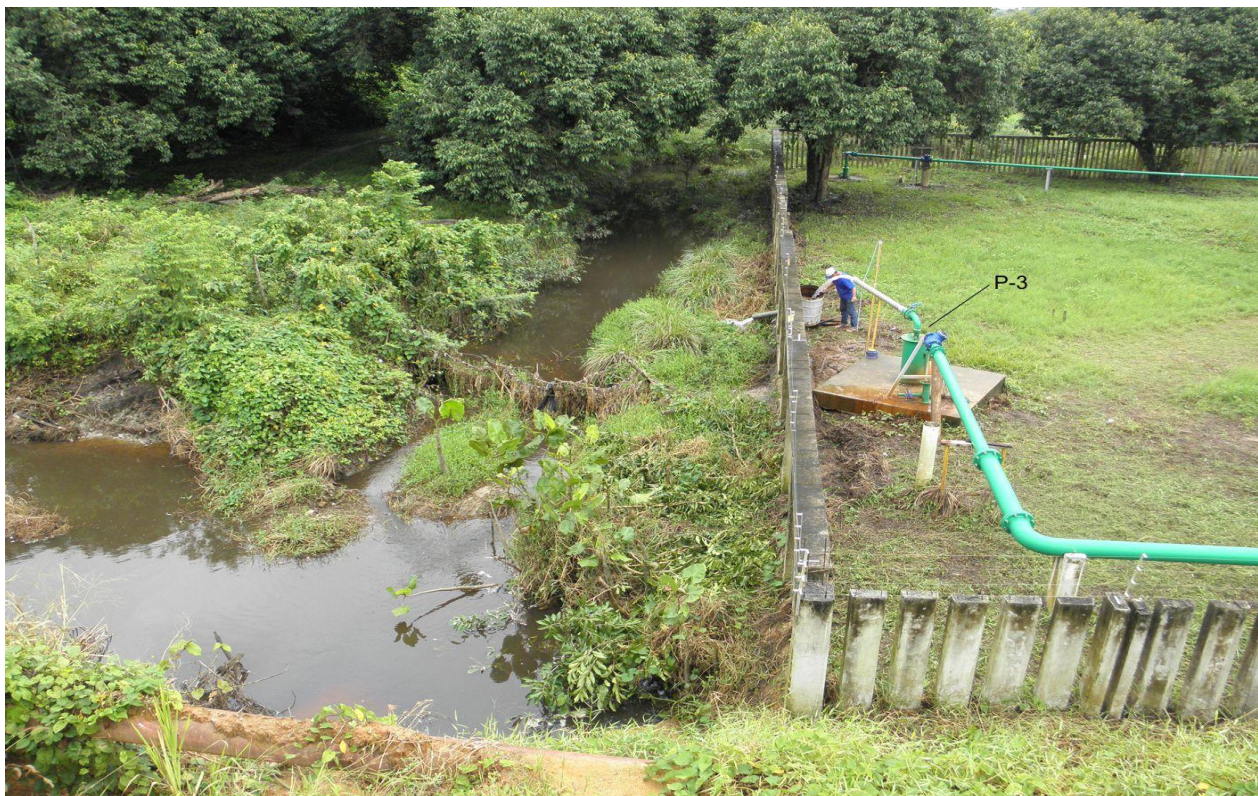
Figura 4.8 Descarga do bombeamento do poço P3 no rio, o tambor tinha a função exclusiva de desviar as águas explotadas para o rio, não tendo nenhuma finalidade de medição da vazão.
