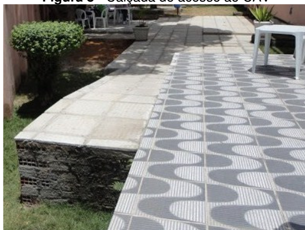
Figura 8 - Calçada de acesso ao CAV
