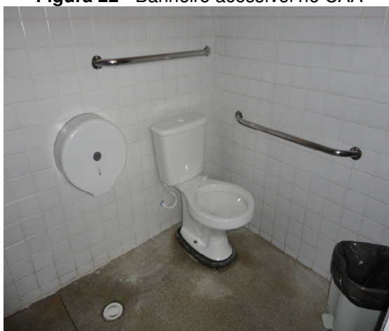
Figura 22 - Banheiro acessível no CAA
