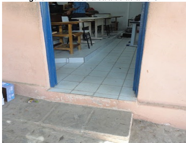
Figura 11 - Acesso à sala de aula no CAV
