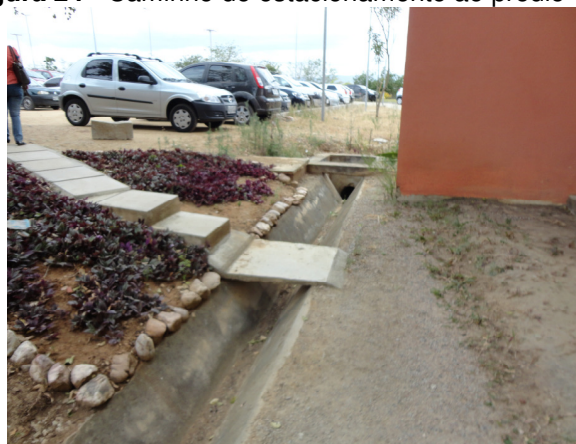
Figura 24 - Caminho do estacionamento ao prédio CAA
