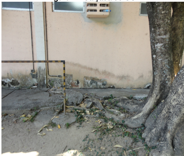
Figura 2 - Calçada do CCB
