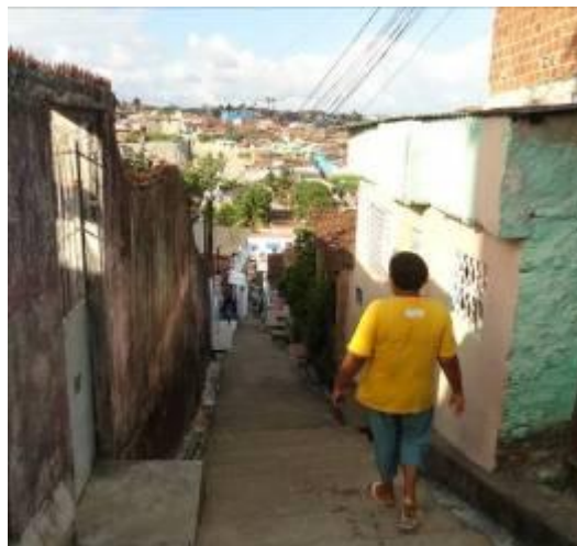
Figura 15: Piso irregular e falta de proteção em escadaria.
