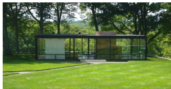
Figura 4 – Glass House, Philip Johnson (exterior), New Canaan, USA, 1949 (disponível em < http://commons.wikimedia.org/ >).
