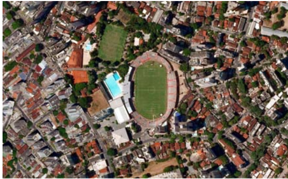
Figura 72 – estádio dos Afilitos e entorno urbano imediato (fonte: imagem GoogleMaps)
