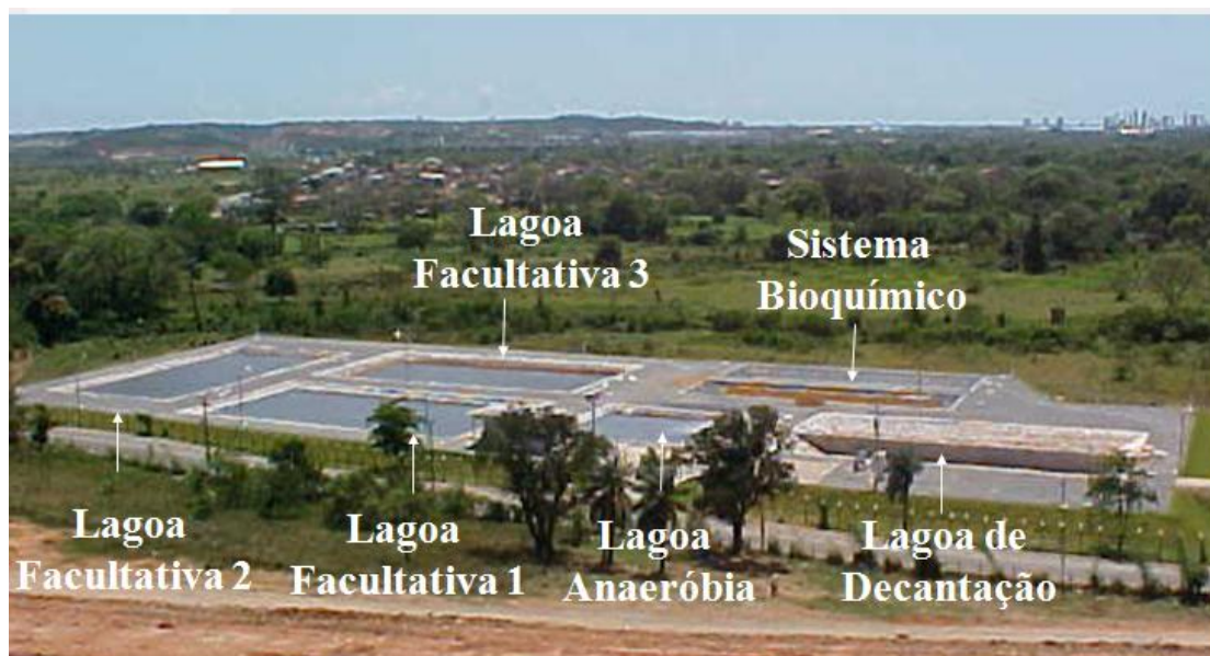
Figura III.3: Estação de Tratamento de Lixiviado do Aterro Controlado da Muribeca.
