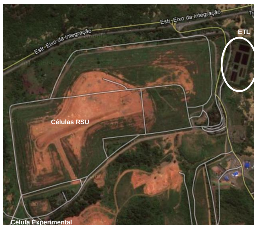
Figura III.2: Vista aérea do Aterro Controlado da Muribeca. Fonte: GOOGLE MAPS (2012) adaptada OLIVEIRA (2013).
