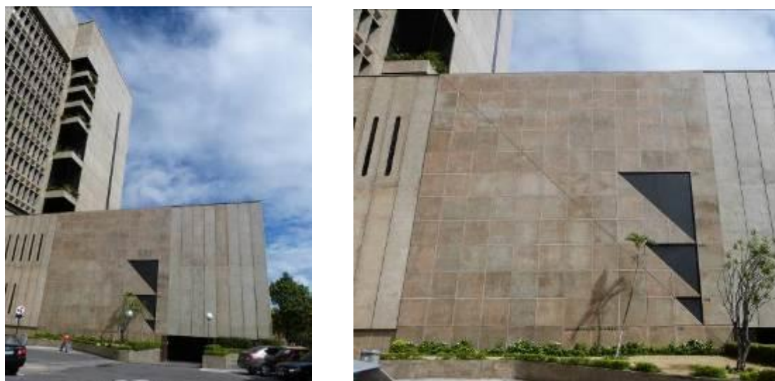
Figura 76 - Coordenação Modular na fachada Fonte: Amanda Casé (2012)
