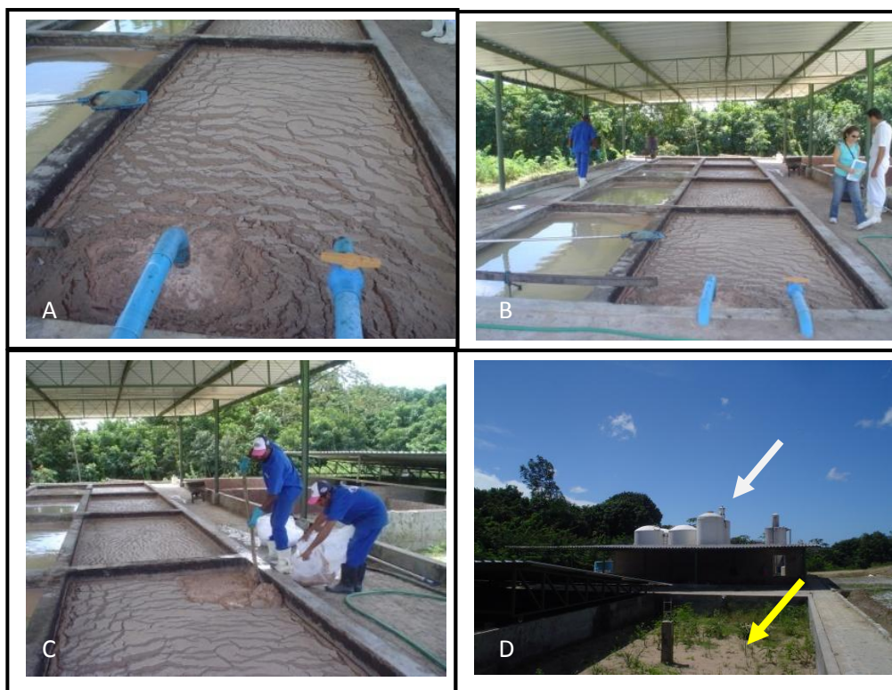
FIGURA 1. Estação de Tratamento de Efluente da indústria de sorvetes. A. Tanque de recepção do efluente; B. Vista parcial dos 8 tanques de decantação; C. Transferência do resíduo para tanques de secagem; D. Tanque de secagem (seta amarela) do resíduo sólido e os biorreatores do tipo UASB (seta branca).
