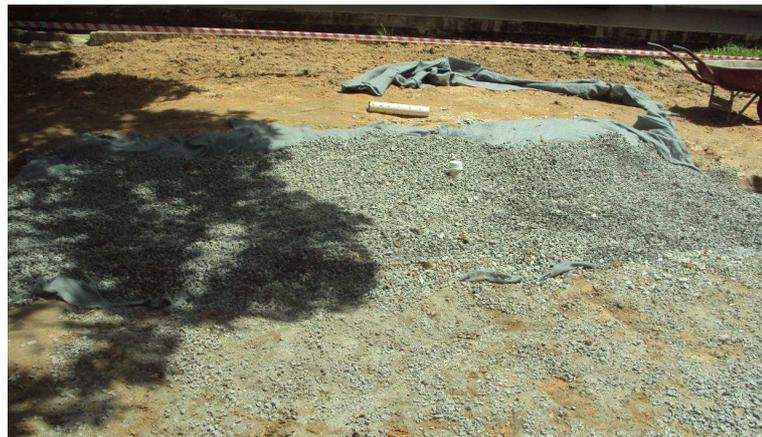
Figura 20 - Cobertura com uma camada de brita para proteção mecânica
