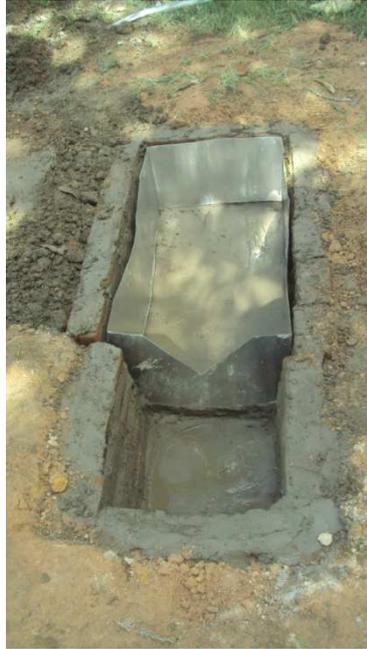
Figura 23 – Instalação do vertedor
