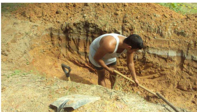
Figura 18 - Escavação manual da trincheira
