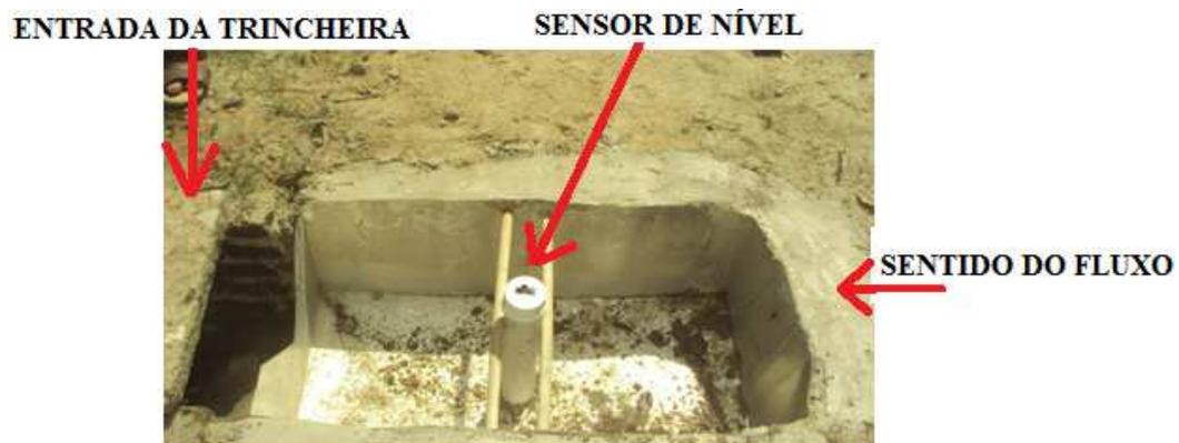
Figura 25 - Sensor de nível instalado no vertedor
