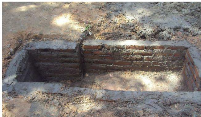
Figura 22 - Construção da caixa do vertedor
