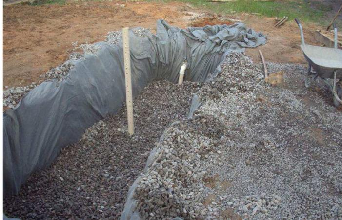
Figura 19 - Preenchimento da trincheira de infiltração com brita
