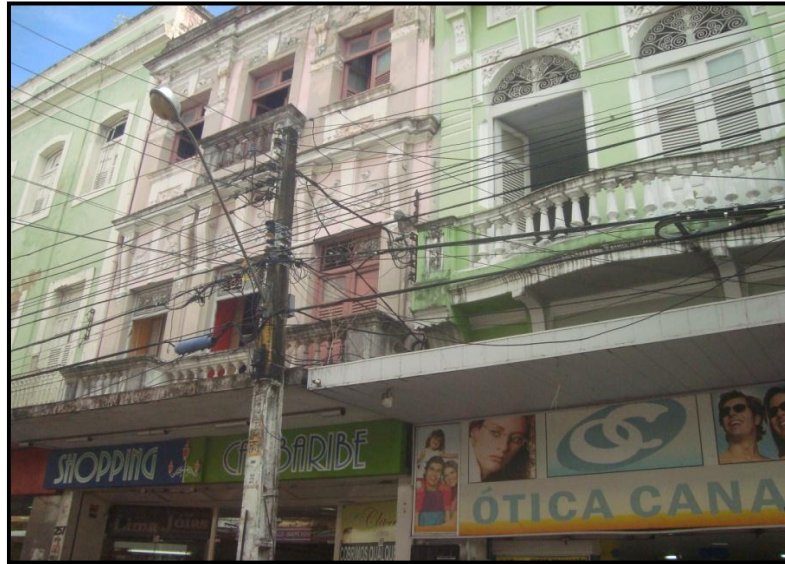
Figura 26 – Rede elétrica irregular, na Rua Imperatriz
