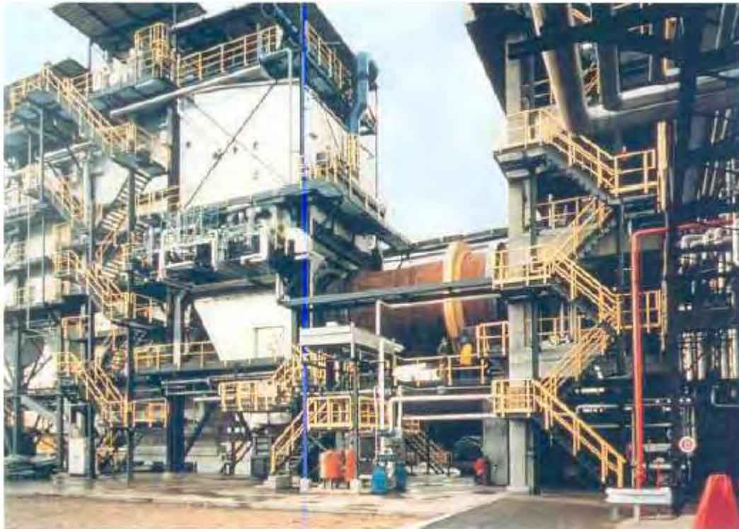
Figura 2.15 - Incinerador em Forno Rotativo para resíduos Industriais.
