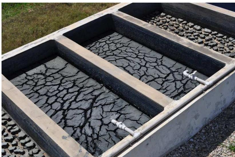
Figura 4 - Lodo têxtil em leito de secagem. Foto da autora.
