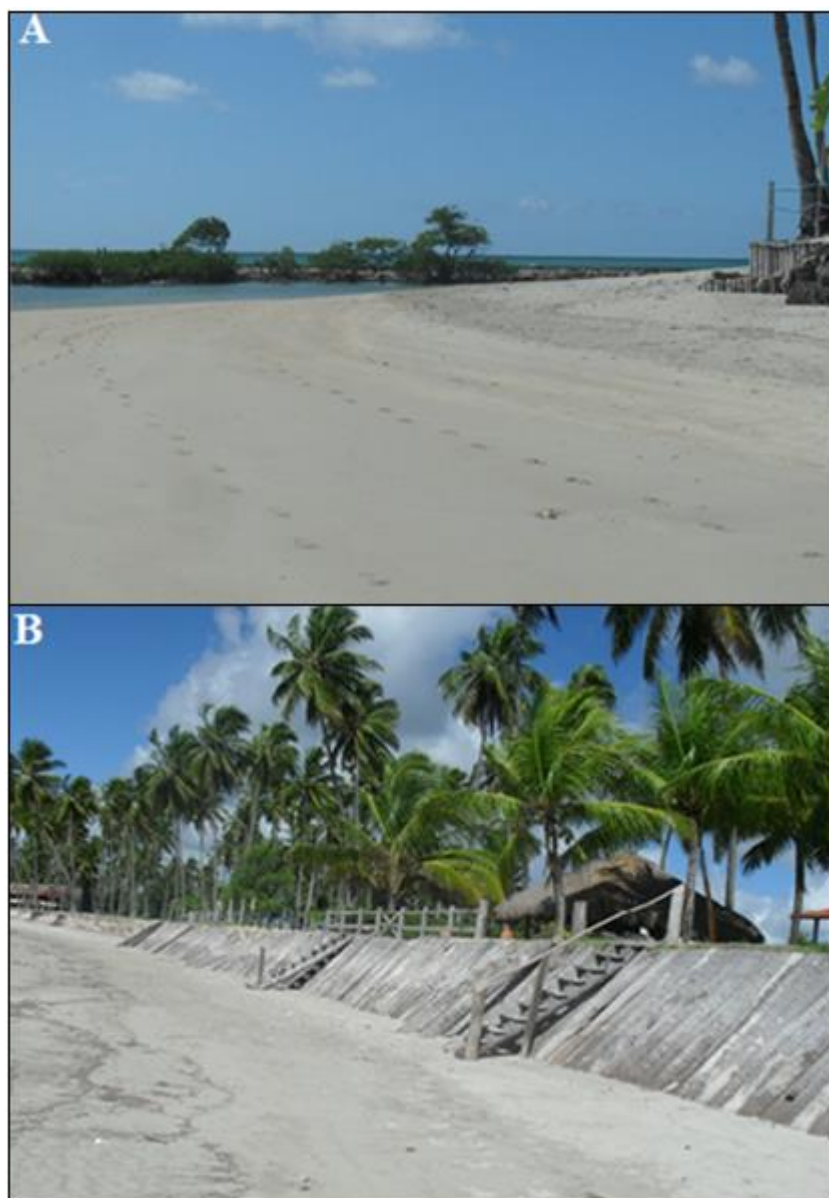
Figura 30: A – Presença de beachrocks na praia dos Carneiros, B – Muro construído com troncos de coqueiros para contenção à erosão na praia de Tamandaré.
