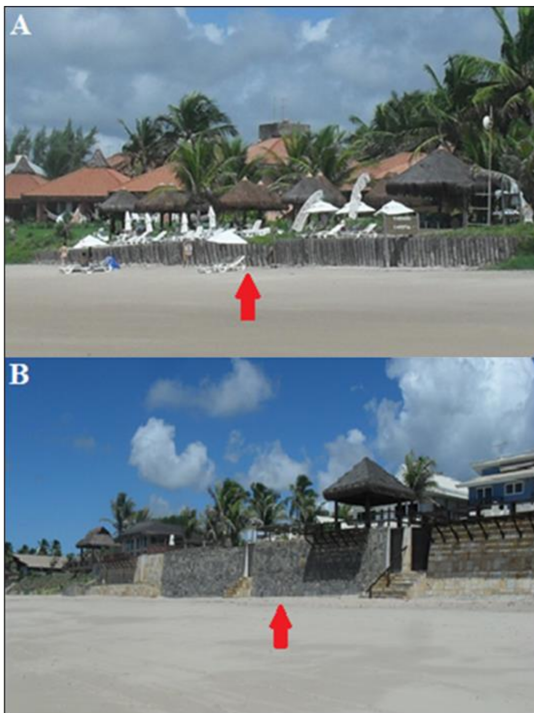
Figura 26: A – Obra de contenção construída a partir de troncos de coqueiros na praia de Porto de Galinhas, B – Muro de contenção construído com rochas e concreto na praia de Toquinho.
