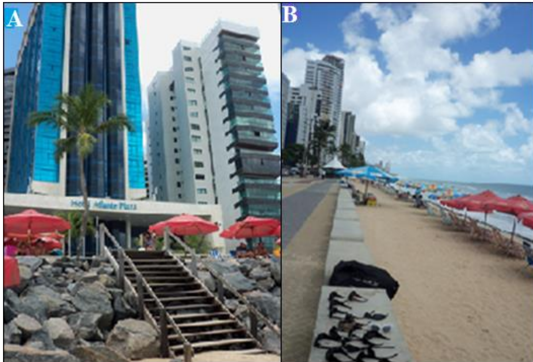
Figura 21 : A e B – Obras de contenção na praia da Boa Viagem.
