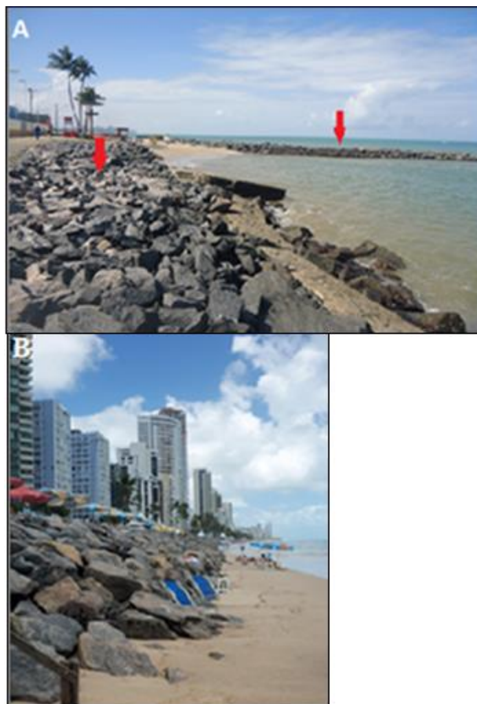
Figura 20: A – Enrocamento paralelo e espigão perpendicular à costa na praia de Candeias em Jaboatão dos Guararapes. Foto do sentido sul para norte; B – enrocamento paralelo à costa na praia de Boa Viagem. Foto do sentido sul para norte.
