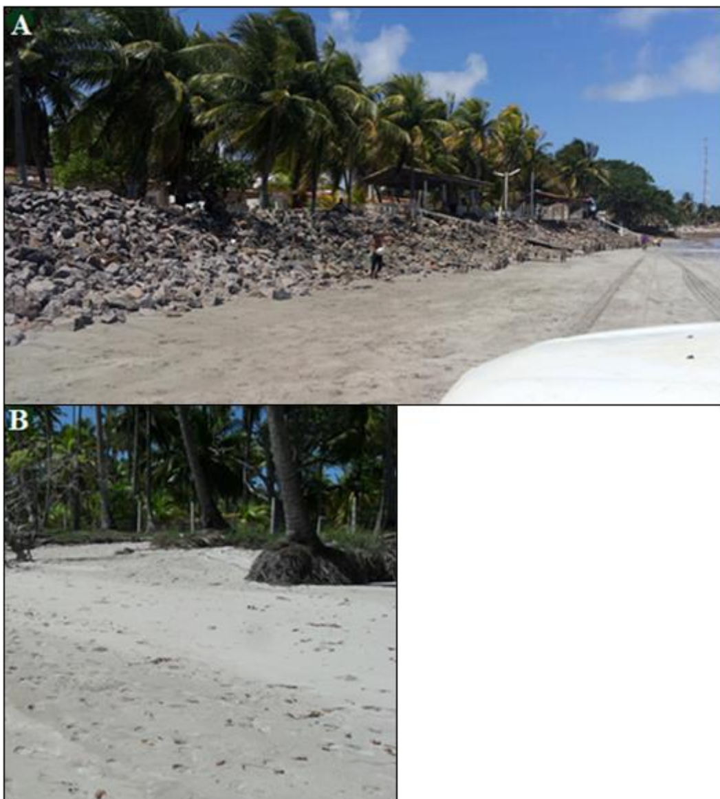
Figura 31: A – Enrocamento aderente na praia de São José da Coroa Grande, B – Raízes de coqueiros expostas na praia dos Carneiros.
