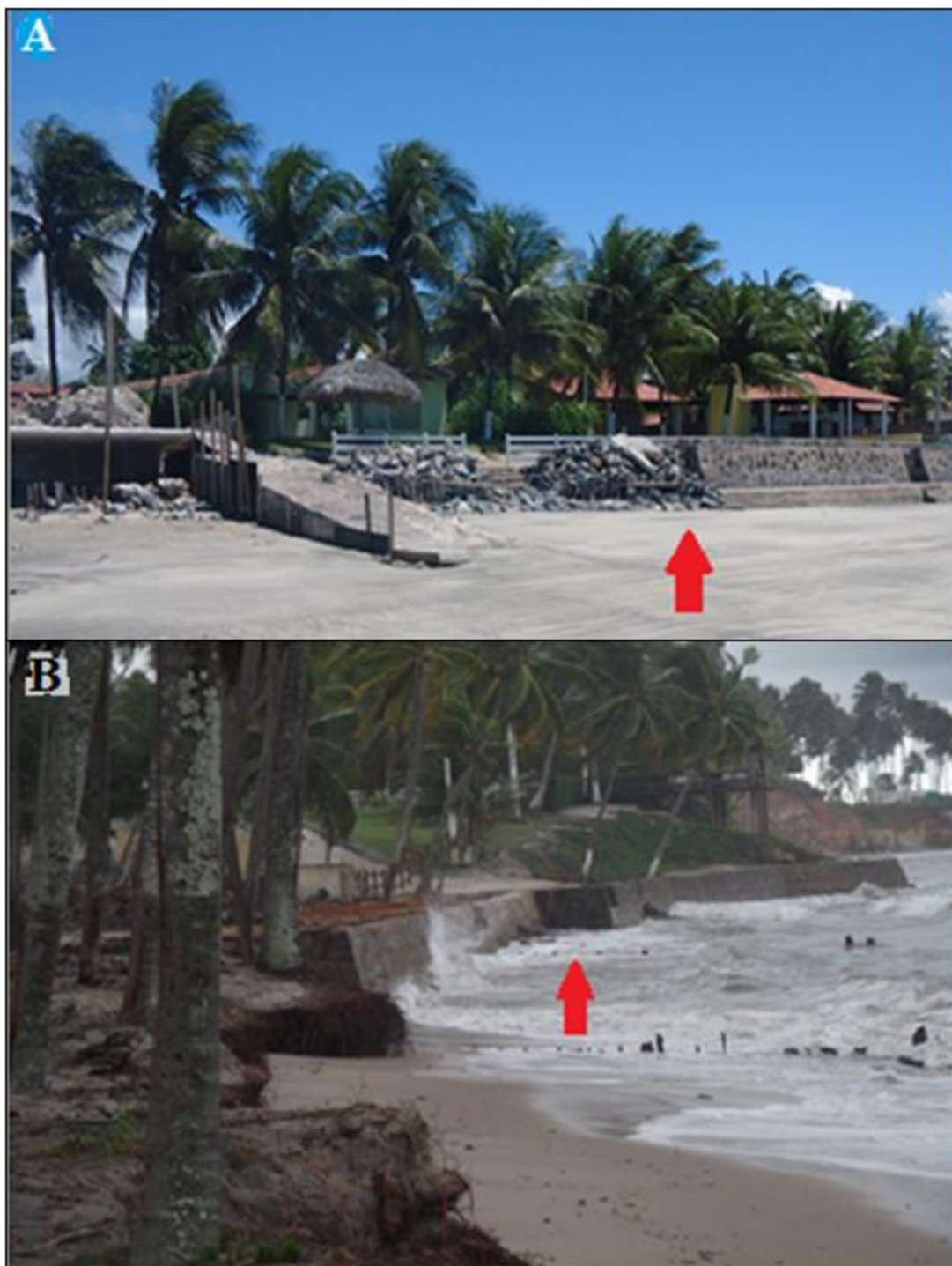
Figura 27: A– Muros de concreto e enrocamento aderente na praia de Serrambi, B – Muros de contenção na praia de Guadalupe.
