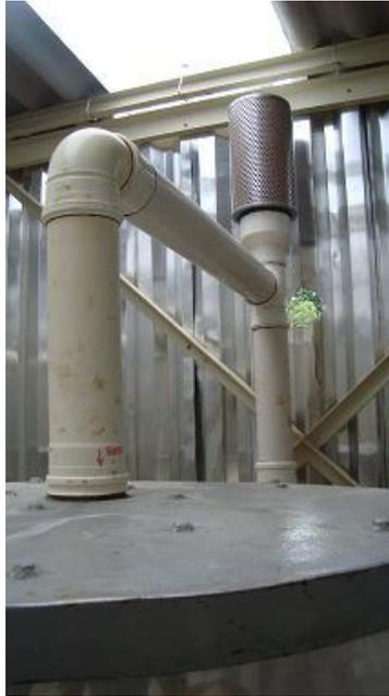
Figura 3.3 - Filtro de cartucho localizado no topo do *riser* da UPF
