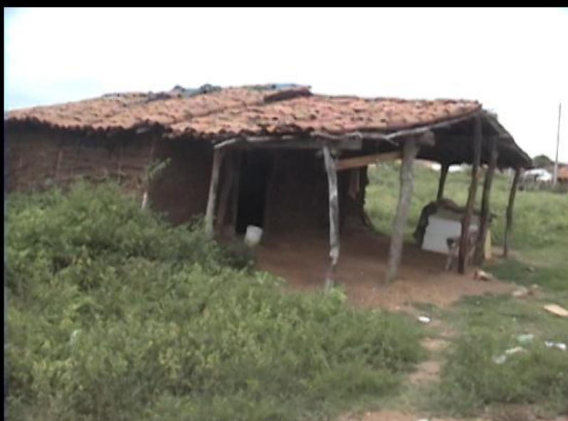
Figura VI – Típica casa de taipa do Rancho: ao redor, mato e esgotos.
